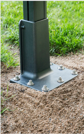
Fästplatta på gjuten plint.
